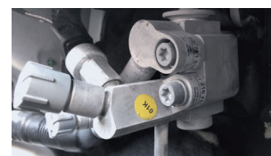
Zdjęcie 3: Należy wymontować zawory rozprężne lub dławiące i zastąpić je adapterami do płukania
